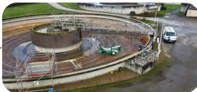
Travaux de réfection du clarificateur
