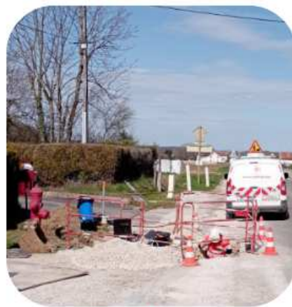
2 raccords + 12 renouvellements branchements ( SEPM )
