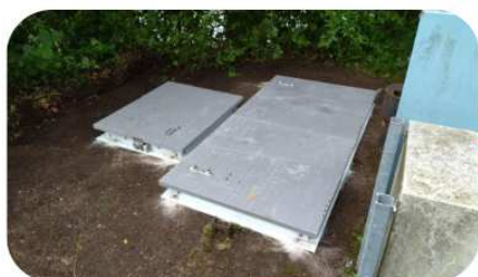
→ Remplacement et ajout barreaudage anti-chute
